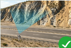
正对监测坡面
